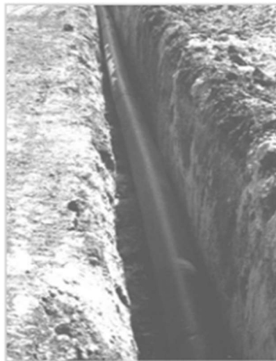
20. ábra: Csőfektetés: a cső aszimmetrikus árokba helyezéssel nem érhető el megfelelő beágyazás!
